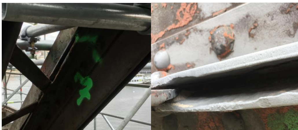
Obr. 35 Zvolené zkušební místo č.7 – Vlevo: před tryskáním, vpravo: po tryskání pomocí křemičitého písku
