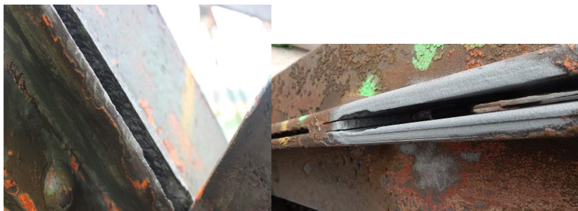
Obr. 28 Zvolené zkušební místo č.4 – Vlevo: tryskání ocelové konstrukce pomocí vodního poprsku, vpravo: následné tryskání pomocí křemičitého písku (po předúpravě štěrby)
