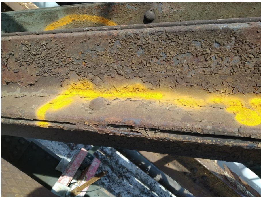
Obr. 2 Typický detail – průchozí štěrbina v diagonále
