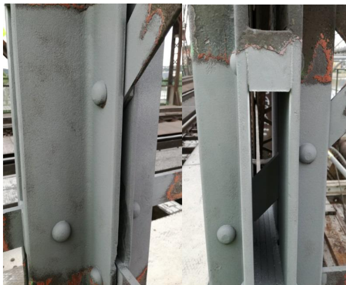
Obr. 42 Zvolené zkušební místo č.20 – po tryskání pomocí křemičitého písku
