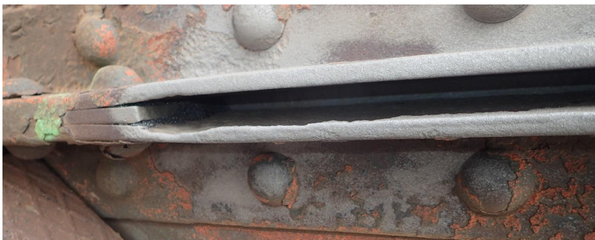
Obr. 44 Zvolené zkušební místo č.9 po tryskání pomocí ocelového abraziva
