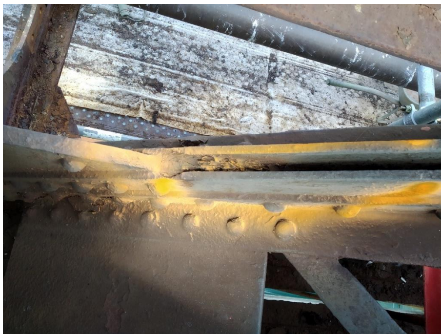
Obr. 5 Typický detail – štěrbina nad dolním pasem
