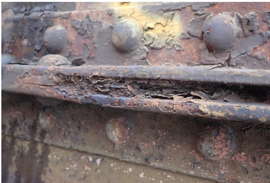
Obr. 10 Zvolené zkušební místo č. 1 – Zleva: Před tryskáním
