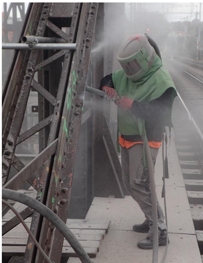
Obr. 39 Zvolené zkušební místo č.8 – tryskání
