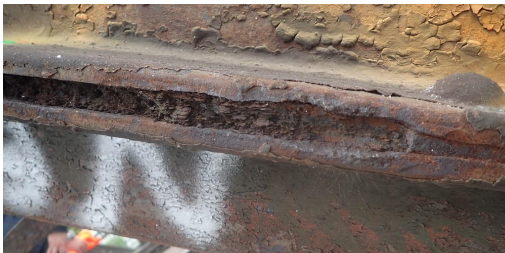
Obr. 30 Zvolené zkušební místo č.5 před tryskáním
