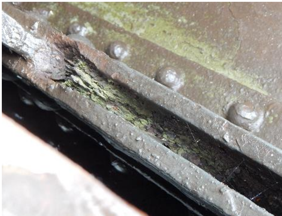
Obr. 15 Zvolené zkušební místo č.2 – Zleva: Před tryskáním
