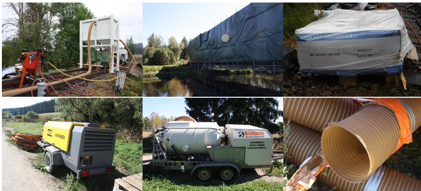
Obr. 3 – Technické vybavení pro odstranění původní PKO
