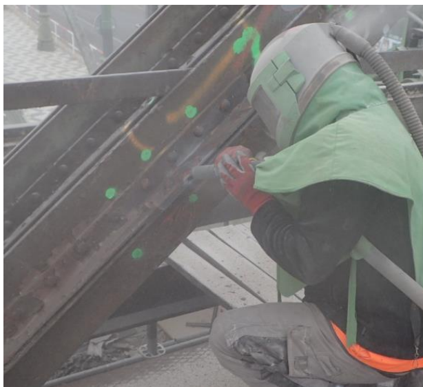
Obr. 25 Ukázka tryskání pomocí křemičitého písku
