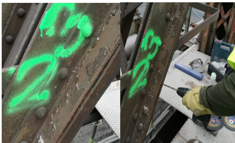
Obr. 48 Zvolené zkušební místo č.23 – Mechanický předúprava štěrbin pomocí vrtacího kladiva a vrtáku do kovu – při provádění čištění
