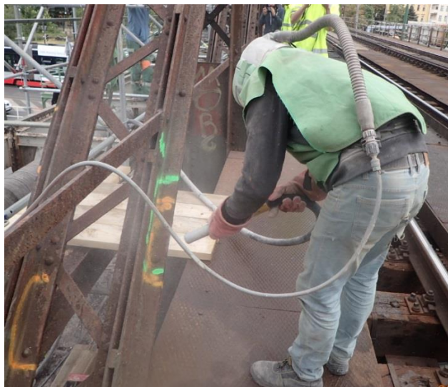
Obr. 24 Zvolené zkušební místo č.4 – Tryskání ocelové konstrukce pomocí křemičitého písku
