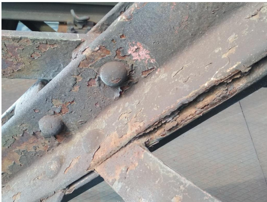
Obr. 4 Typický detail – neprůchozí štěrbina v diagonále s těžkým přístupem
