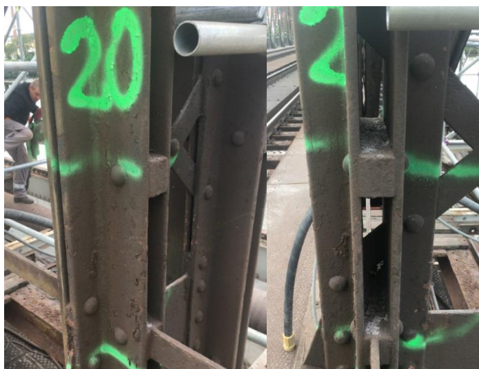
Obr. 41 Zvolené zkušební místo č.20 – před tryskáním pomocí křemičitého písku
