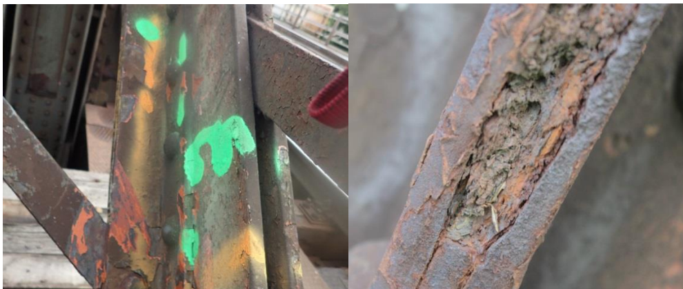
Obr. 20 Zvolené zkušební místo č.3 – Před tryskáním
