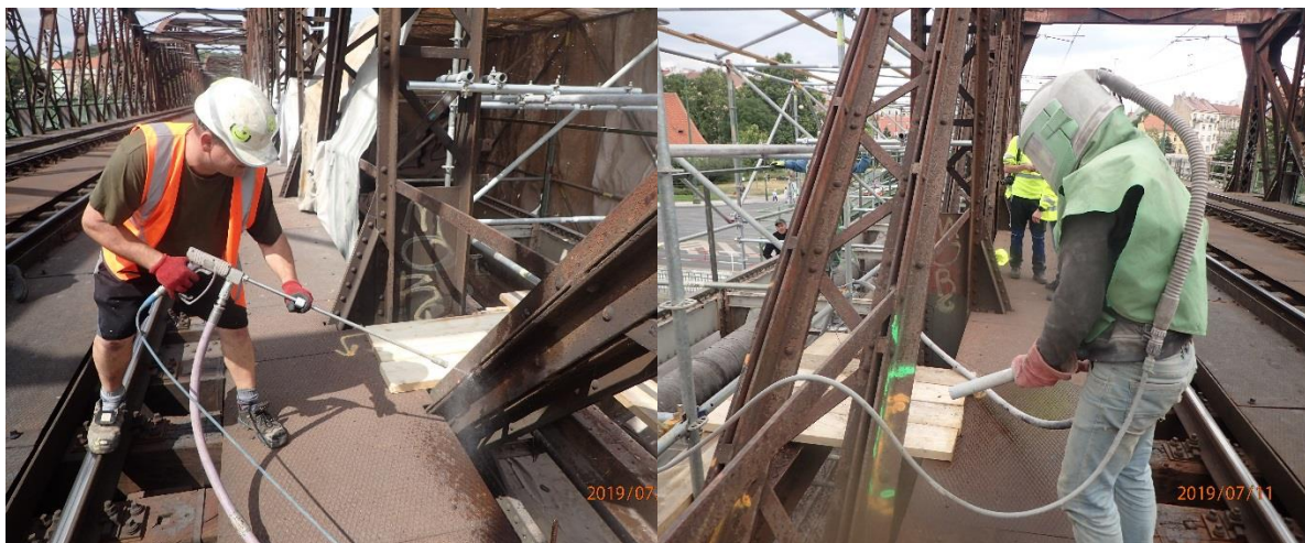
Obr. 27 Neprůběžná štěrbina zanesená korozními produkty a dalšími nečistotami, tryskání vodním paprskem a pískem
