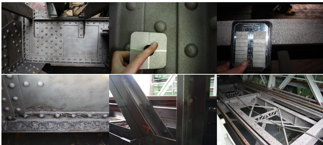
Obr. 4 – Předúprava povrchu ocelové konstrukce mostu SO201
