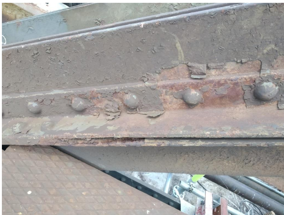
Obr. 3 Typický detail – neprůchozí štěrbina v diagonále, s podkorodovaným případně odprýskaným nátěrovým systémem
