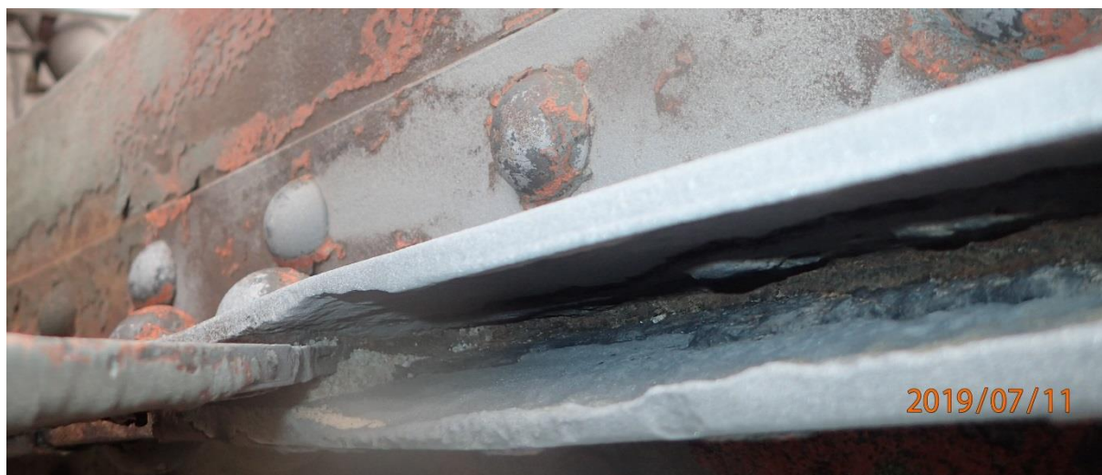
Obr. 36 Zvolené zkušební místo č.7 –po tryskání pomocí křemičitého písku
