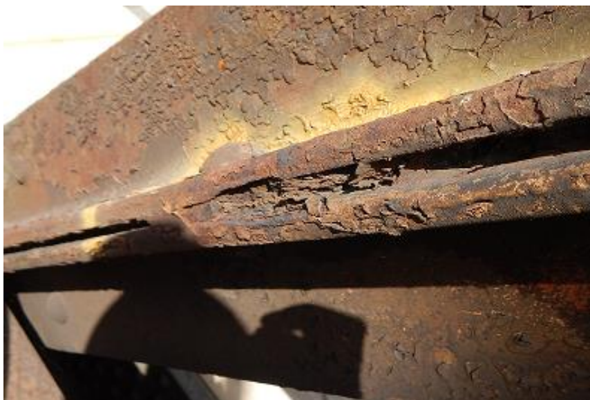
Obr. 26 Neprůběžná šířbina zanesená korozními produkty a dalšími nečistotami (IV – neprůběžná)
