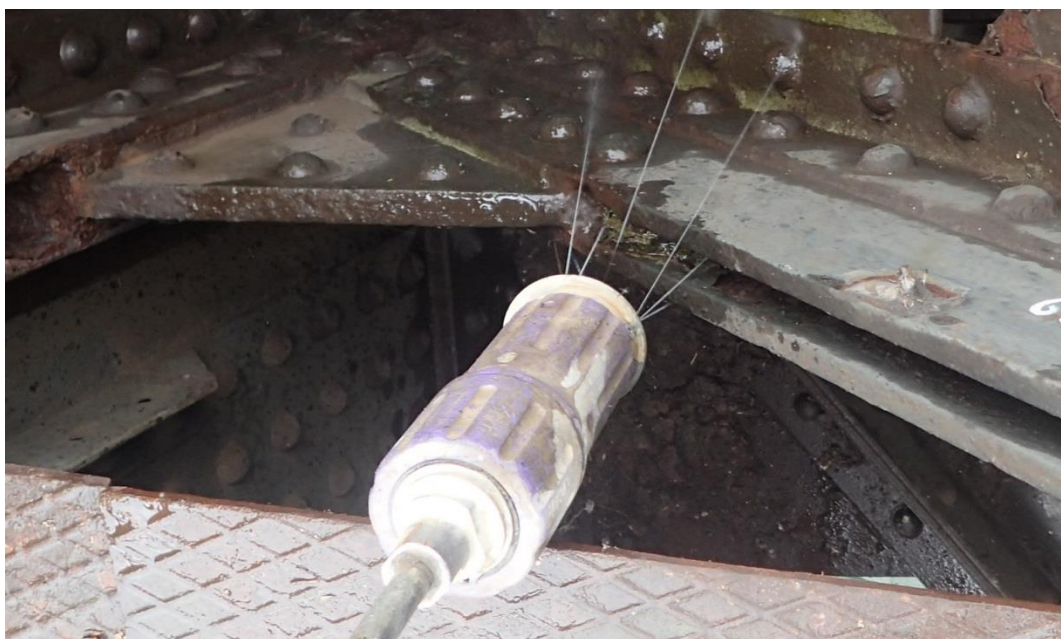
Obr. 16 Zvolené zkušební místo č.2 – Zleva: Před tryskáním s rotační tryskou
