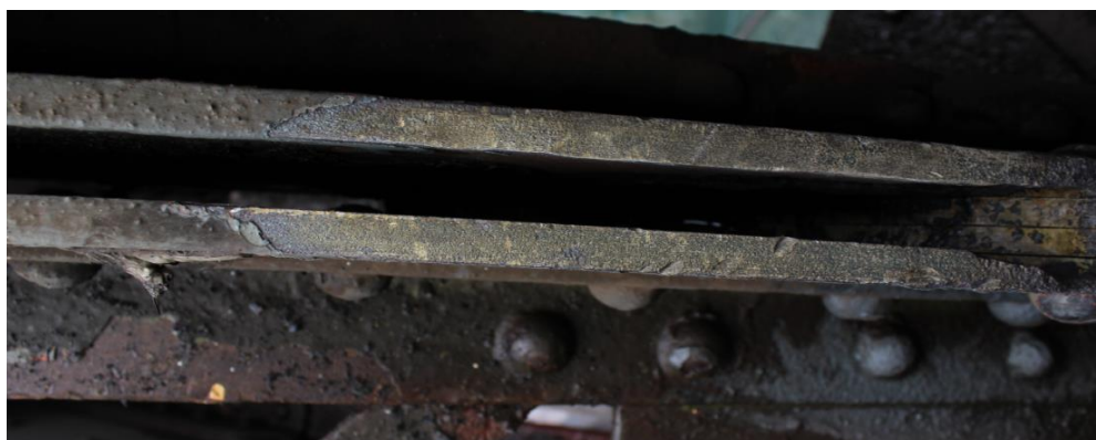
Obr. 22 Zvolené zkušební místo č.3 – Po tryskání
