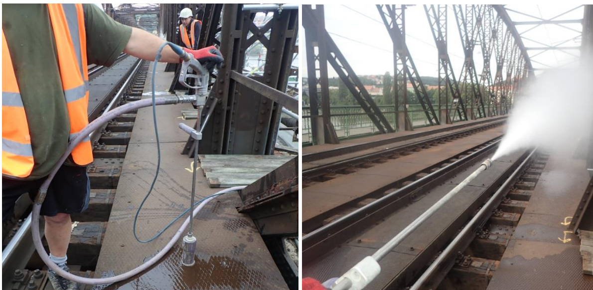
Obr. 9 Vlevo: Ukázka rotační trysky pro tryskání vodním paprskem, vpravo: ukázka demoliční trysky s vodním paprskem o síle až 2500 bar
